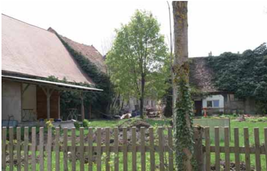
Anbau „Am Wall 4“ - Rückseite Bestand
