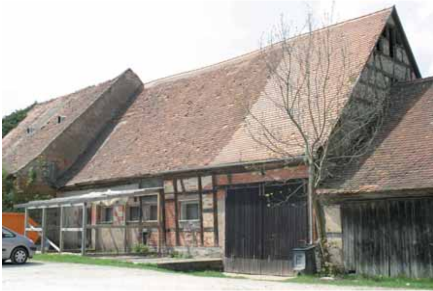
Anbau „Am Wall 4“ - Bestand
